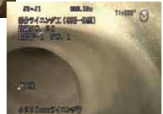
施工後 取付管部分 (ライニング)
