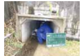
到達側 施工状況
