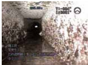
角管部 施工前
