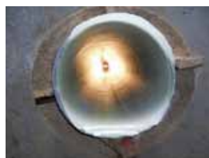
施工後 たるみ改善
