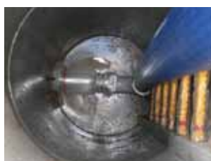
取付管ライニング施工中
