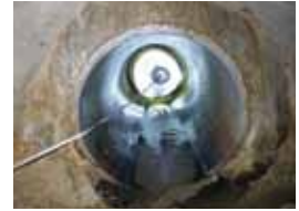
到達側 光硬化状況
