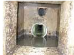
樋管口ゲート内
