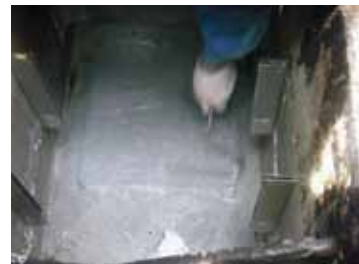
含浸した材料を設置する
