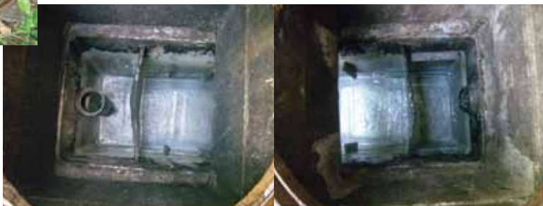
施工完了後の写真
