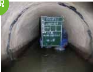
人孔より26m地点の施工前
