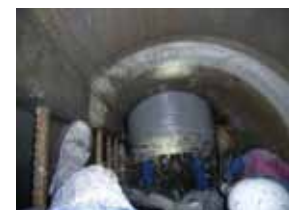
施工機の挿入状況 (水量はインバートいっぱいまであり)
