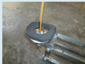
注入ロボットの注入口
