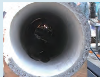
開放後の少量の残モルタル
