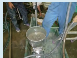
充填モルタルの圧送
