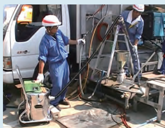
ホース内の残モルタルの吸引
