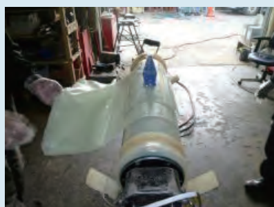
補修材料の巻き付け
