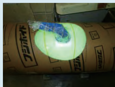
補修材硬化中
