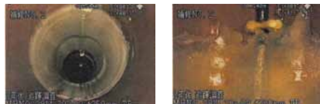
8. 光ファイバー布設後の部分補修、光硬化
