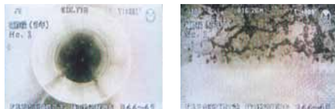
8. 光ファイバー布設後の部分補修、光硬化
