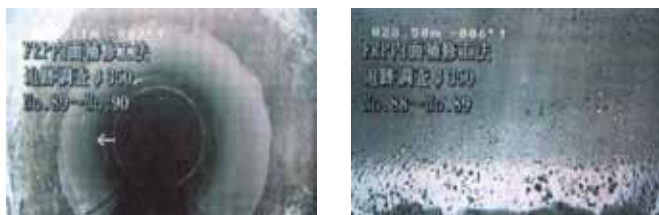
4. φ350 (HP) 補修箇所 (クラック B、浸入水 B)、熱硬化
